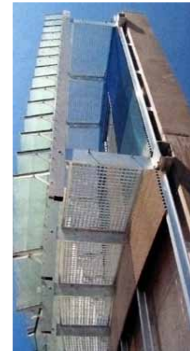
[Fig. 6] Torre Agbar, Barcelona. Envolvente construida capa a capa sobre una base continua de hormigón armado.
