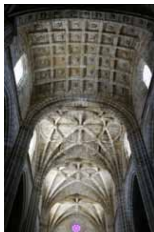
[Fig. 8] Diferentes tipos de superficies generadas a partir de la utilización de curvas definitorias. Figuras superiores, modelos de bóvedas hispano-musulmanas según Torres Balbás (arcos entrecruzados). Figura inferior izquierda, bóveda casetonada en la Iglesia de San Miguel de Morón, Sevilla (traslación de arcos de directriz idéntica en la dirección corta), Biblioteca Nacional de París, H. Labrouste (bóvedas baidas de meridianos y paralelos)
