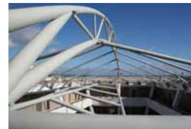
[Fig. 2] Cubierta de edificio de oficinas en San José de la Rinconada, Sevilla (J.C. Gómez y S. Bermejo Oroz, 2007)
