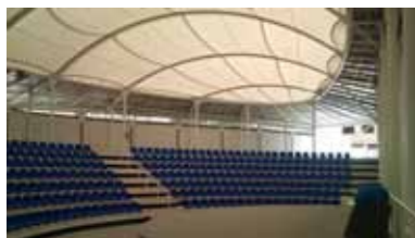
[Fig. 10] Auditorio Municipal, Gines (Sevilla). J.C. Gómez de Cózar y S. Bermejo Oroz. Malla compuesta por arcos continuos paralelos de curvatura idéntica y barras transversales de unión.
