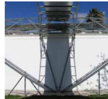
[Fig. 1] Piscina Municipal de Gines, Sevilla (J.C. Gómez de Cózar y Rafael García Diéguez, 2001)
