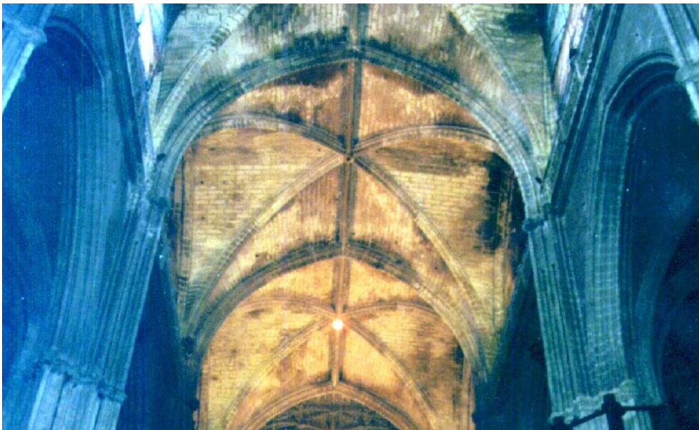
Fig. 6. Bóvedas de la nave principal de la Catedral de Sevilla (cuatrimpartitas)
