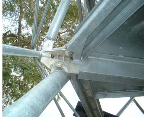
Fig. 10. Diferentes soluciones de uniones patentadas
