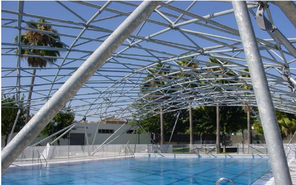
Fig. 12 . Piscina semiolímpica cubierta (2001-2003)
