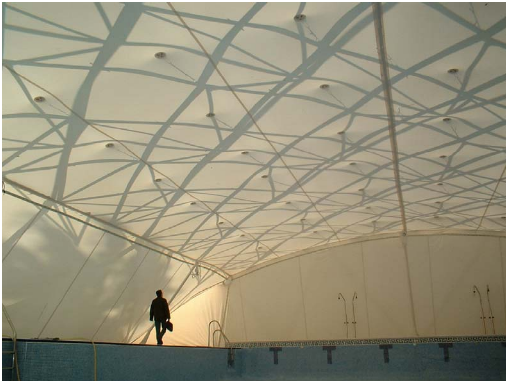
Fig. 11. Piscina semiolímpica cubierta (2001-2003)
