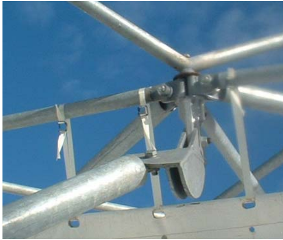
Fig. 10. Diferentes soluciones de uniones patentadas
